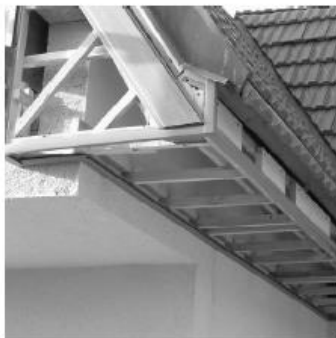
osazené ukončovací profily a 1. lamela
